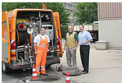
Bildbezeichnung: von links nach rechts: Herr Kreis, Kanal-Türpe GmbH, Herr Ober, EnBW, Olaf Türpe, Geschäftsführender Gesellschafter, Kanal-Türpe GmbH.
